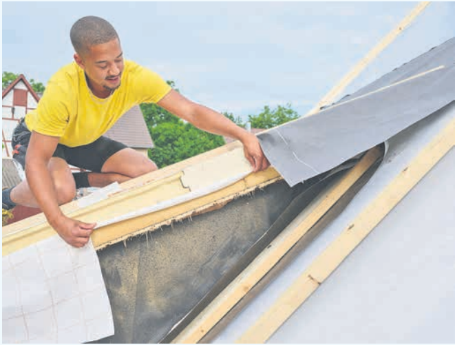
PU-Dämmung wiederverwenden: Auf die bestehende PU-Dachdämmung und einer Dampfbremse wird eine neue PU-Dämmung verlegt. (Foto: epr/IVPU)
